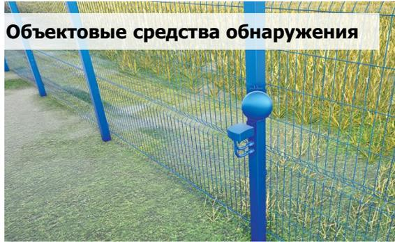
Средства обнаружения непрерывно отслеживают состояние объекта. Нарушение целостности металлического периметра, движение в закрытой зоне и другие нежелательные события выводят сигнал «тревога» на экран оператора.
