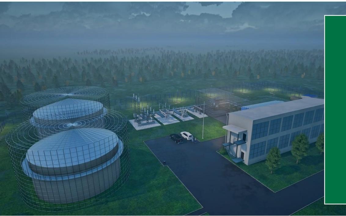
**Наши инженерные ограждения защищают объект от осколочного воздействия взрывных устройств, а также, от взрывной волны при подрыве беспилотного летательного аппарата. Защитные конструкции эффективны при таране БПЛА, сбросе и метании взрывных устройств в любом направлении, в том числе сверху.**
